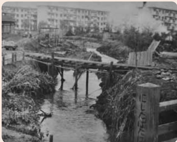
写真1「西田端橋（荻窪二丁目8番附近・昭和37年頃）」（当館蔵） 団地入居者により人口が増えたためおこなわれた、橋の補強と善福寺川の護岸工事の様子。写真上部に「荻窪団地」が写っている。当団地は、平成23年（2011）に建て替え、「シャレール荻窪」と名称変更した。
