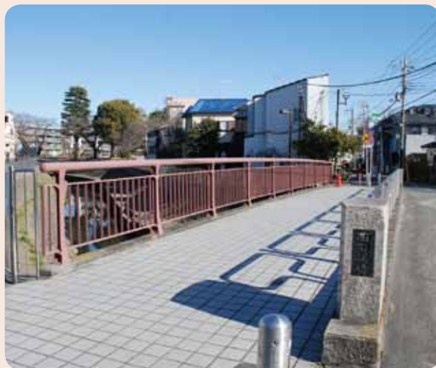
写真2「現在の西田端橋」（筆者撮影）
