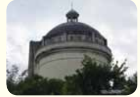
旧野方配水塔(中野区江古田)
