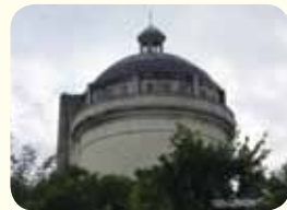
旧野方配水塔(中野区江古田)
