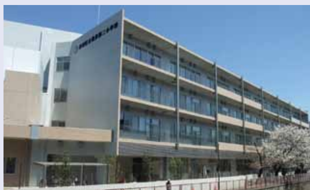
新校舎外観(荻窪橋から撮影)
