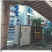
タウンセブン前歩道橋下防災倉庫
